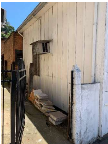
Imagem 4 e 5 – Fachada oeste e fachada leste. Caixas de ar condiciona que deverão ser retiradas. (2021)
